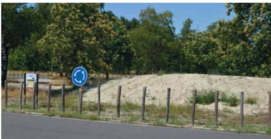
In Pelt (Bosland) zorgen de natuurlijk ingerichte rotondes ook voor waterbergend vermogen.
